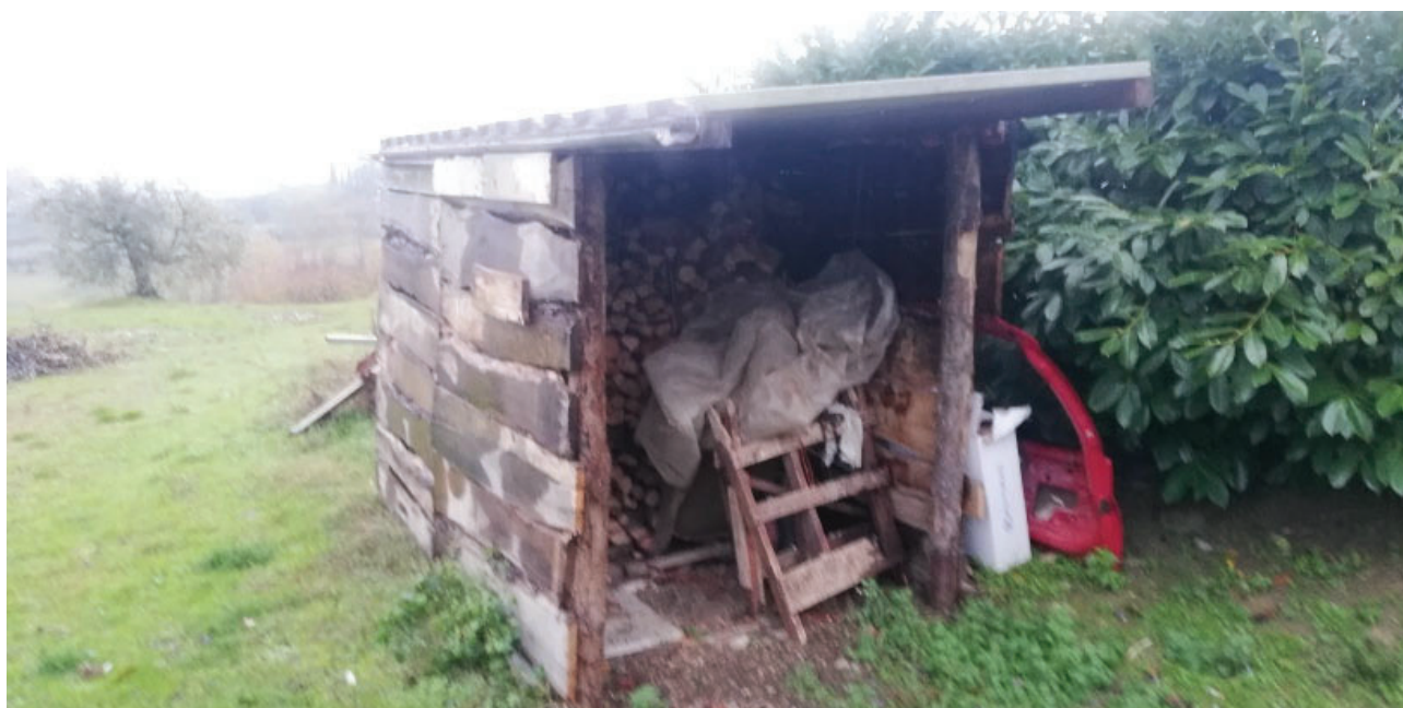
Parate da demolire
