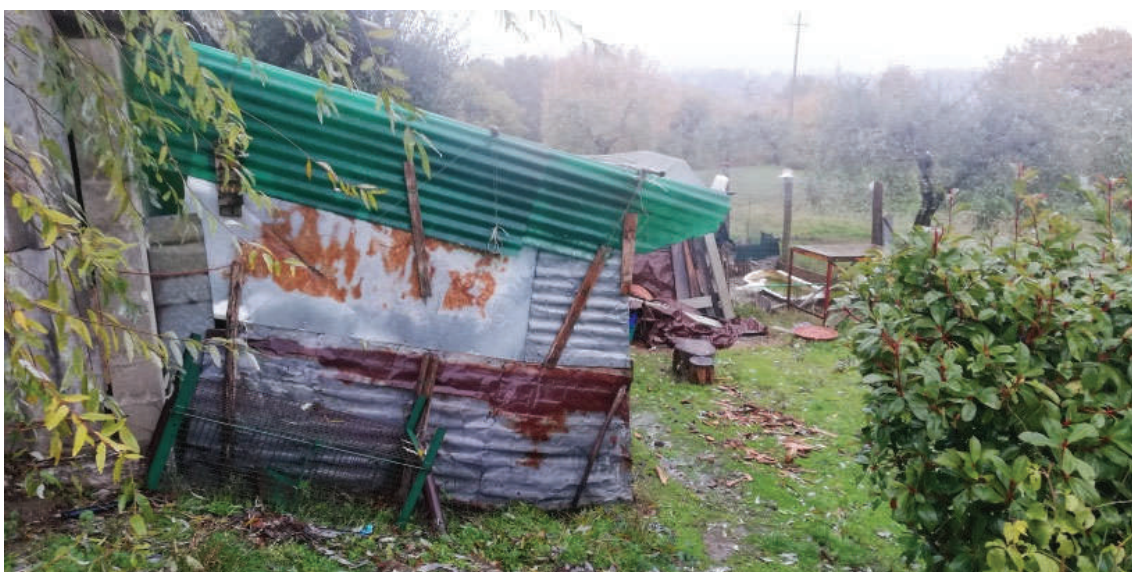
Parate da demolire
