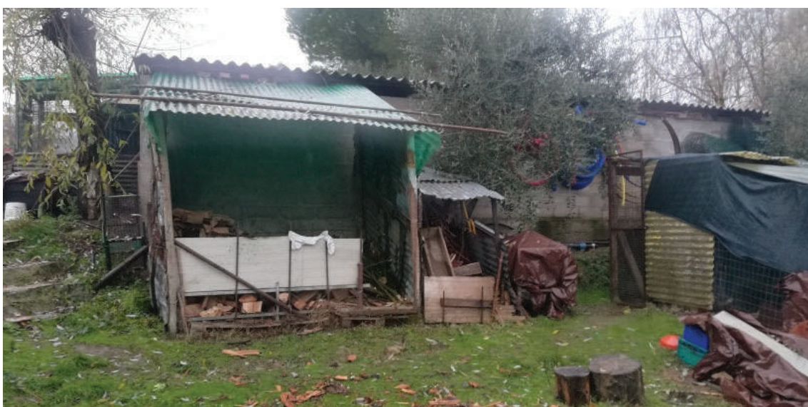
Parate da demolire
